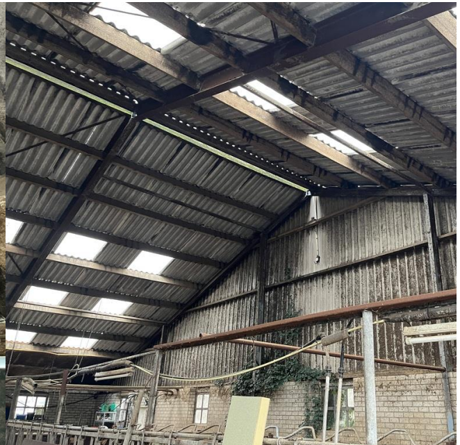
foto 9 binnenzijde loods met asbestvrij dak
