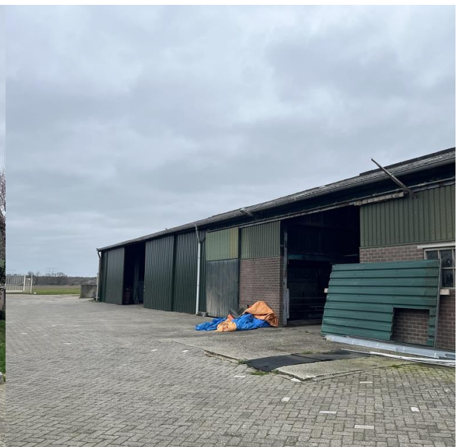
foto 5 loods voorzien van asbestvrij dak, zie M02
