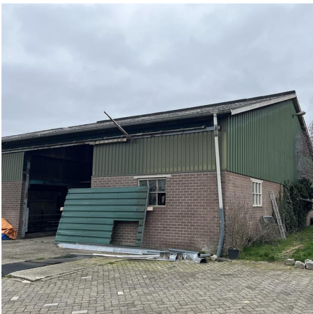
foto 4 loods voorzien van asbestvrij dak, zie M02
