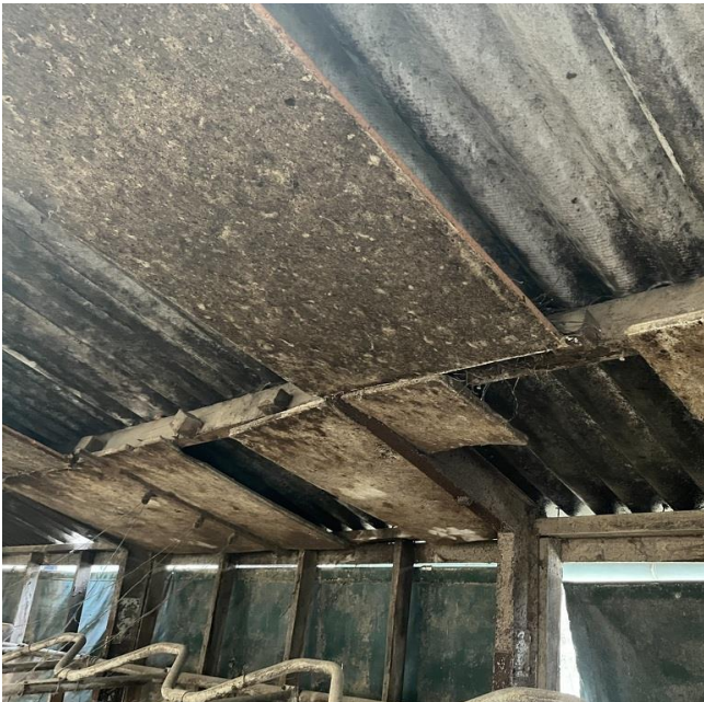
foto 8 binnenzijde stal, isolatie en afwerking asbestvrij
