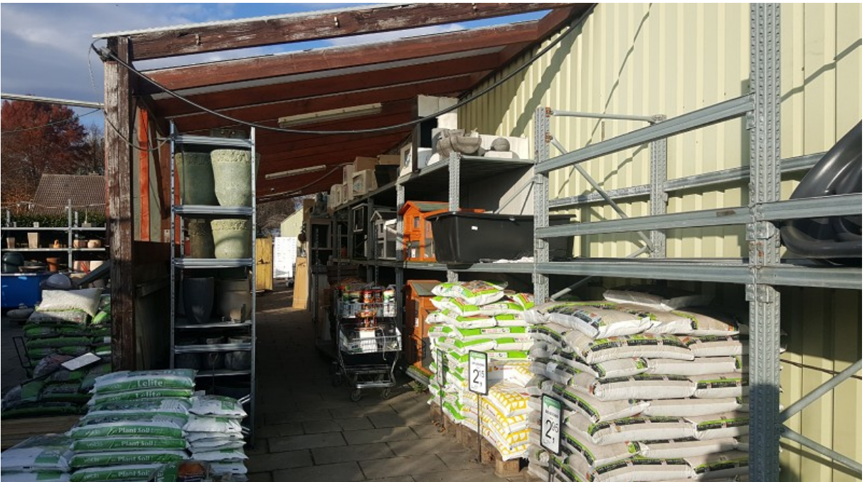
Noordelijk deel van de westelijke gevel met overkappingen en stellingen. uiterst links op de achtergrond de woning waar geen werkzaamheden zullen plaatsvinden. Foto. B. Verhoeven | Ecoresult B.V.
