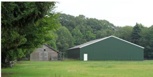
Agrarische bebouwing aangrenzende perceel
