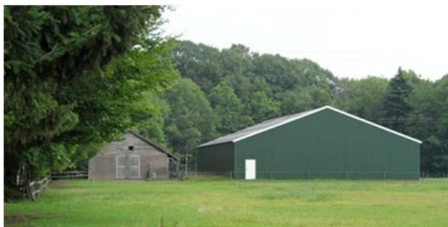
Agrarische bebouwing aangrenzende perceel
