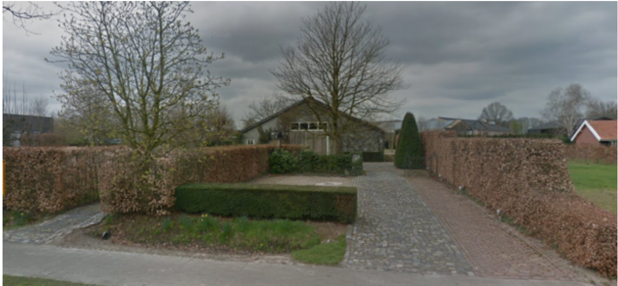
Aanzicht van de bestaande situatie. (bron: google.nl)
