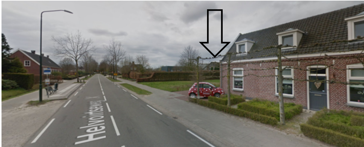
Foto van de Helvoirtseweg met bij de pijl de bestaande loods. (bron: google.nl)
