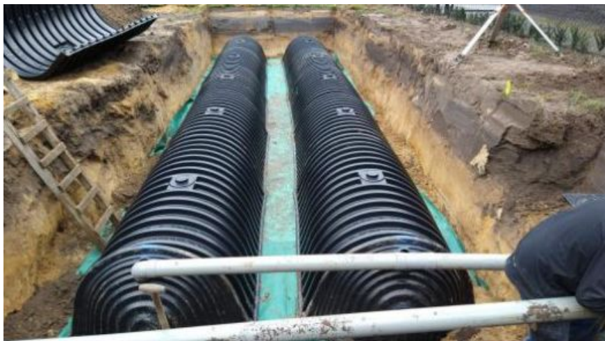
Afbeelding 2: Infiltratietunnels in lengte koppelbaar voor het creëren van grote regenwaterbuffers
