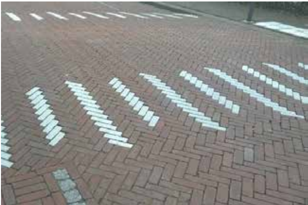
Voorbeeld in te passen verkeersdrempel
