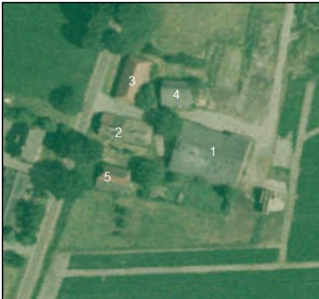
Afbeelding 4: Luchtfoto Heikant 8 te Moergestel in 2000 (bron: atlas.brabant.nl/ArcGIS )
