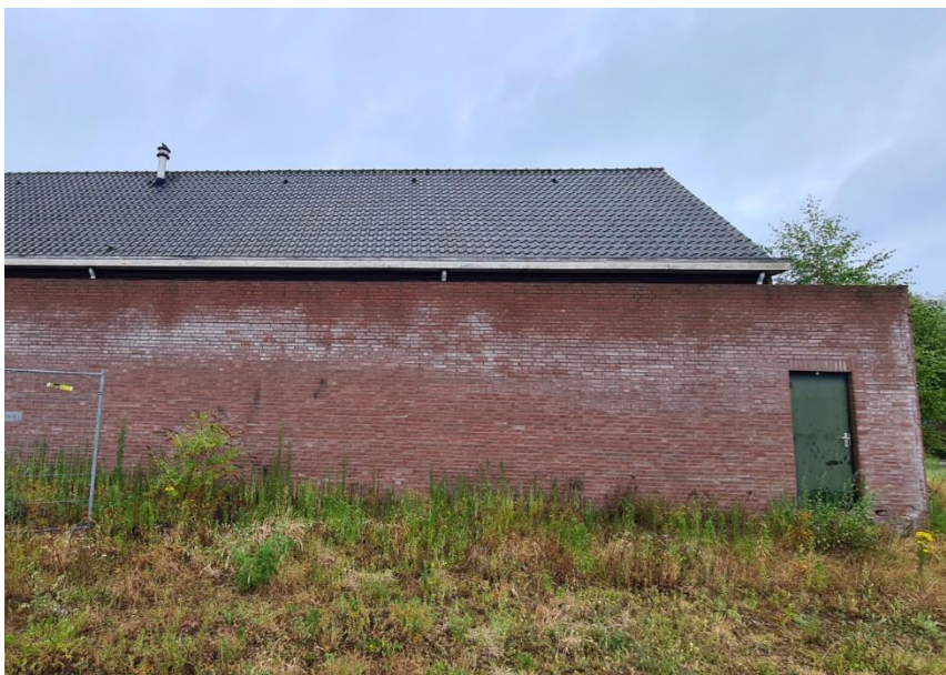
Figuur 5: Achterzijde schoolgebouw
