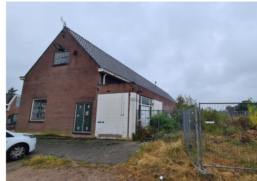
Figuur 4: West- en achterzijde van voormalig schoolgebouw
