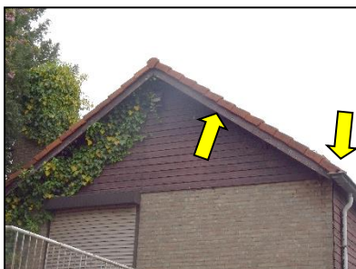
Figuur 7. Woonhuis met ruimte langs de dakrand en dakgoot.
