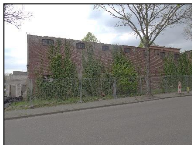
Figuur 8. Voormalige kartonnagefabriek met klimop groeiend aan de gevel.
