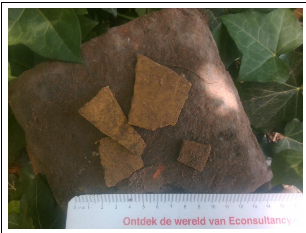
Asbestverdacht materiaal gat 11.
