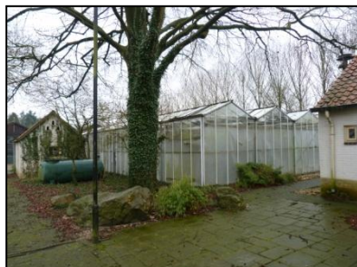
Figuur 6. Kas en bijgebouw achter villa.
