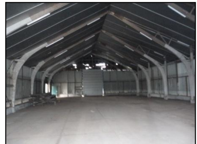
Figuur 14. Binnenzijde stalen loods.
