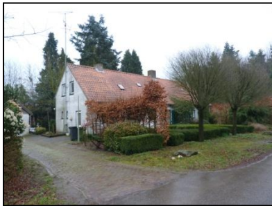
Figuur 21. Twee bedrijfswoningen.
