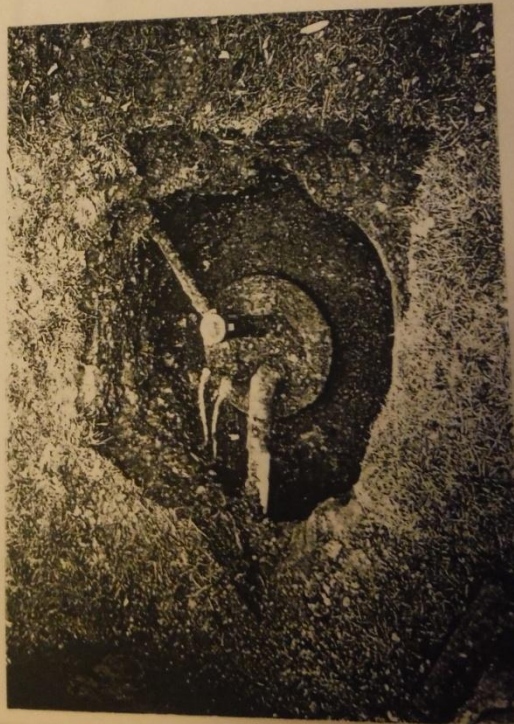
Foto 2: situatie na ontgraving
