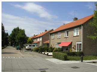
Woningen gebouwd op een meer geïndustrialiseerde bouwwijze.
