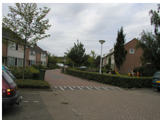
Gewelbeplating kenmerkt de woningbouw uit deze periode.
