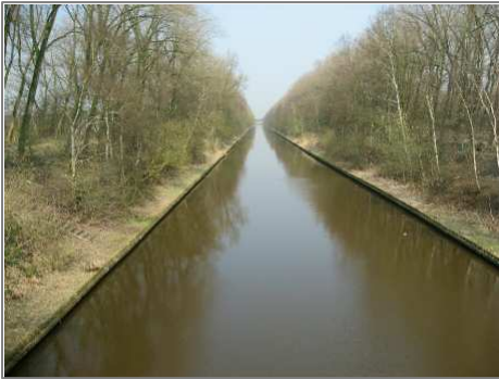
Beatrixkanaal in noordelijke richting gezien vanaf de Eindhovensedijk
