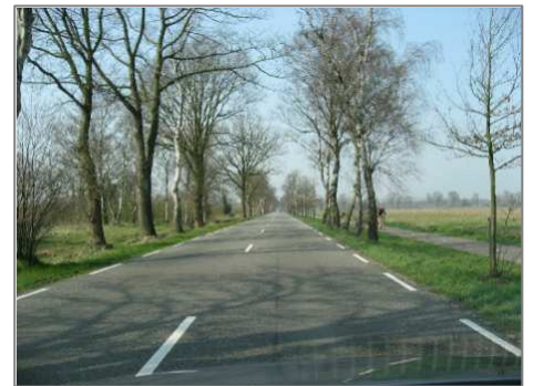
Eindhovensedijk in oostelijke richting
