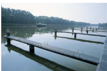
Steigers t.b.v. de passantenhaven
