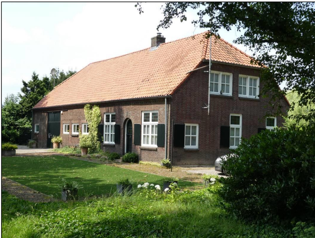
Figuur 5: Voor- en Kopgevel langgevelboerderij Spoordonkseweg 137
