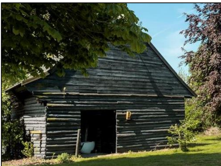
Afbeelding 21: Middelste bijgebouw in zijn huidige staat
