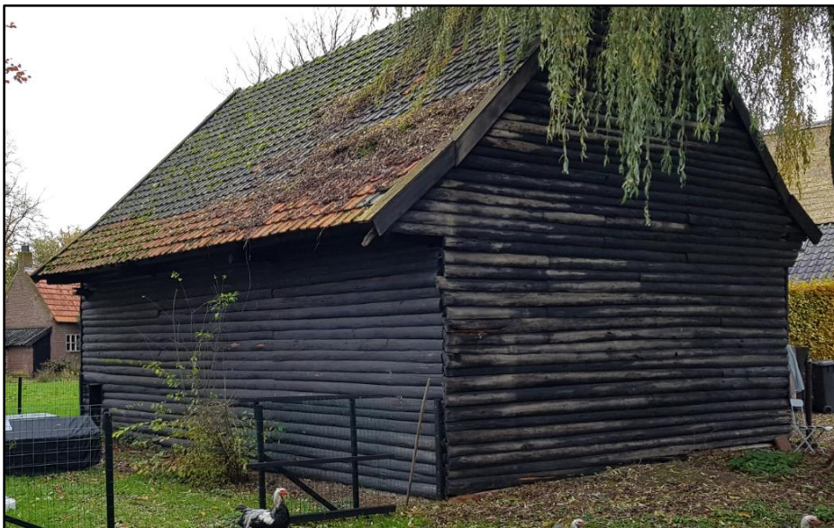
Afbeelding 20: Middelste bijgebouw in zijn huidige staat
