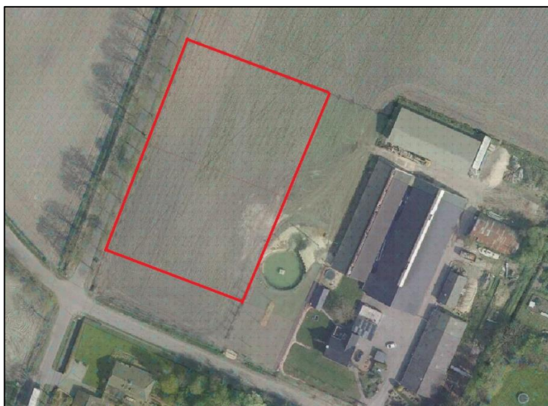
Figuur 1: Luchtfoto waarop het plangebied is omkaderd
