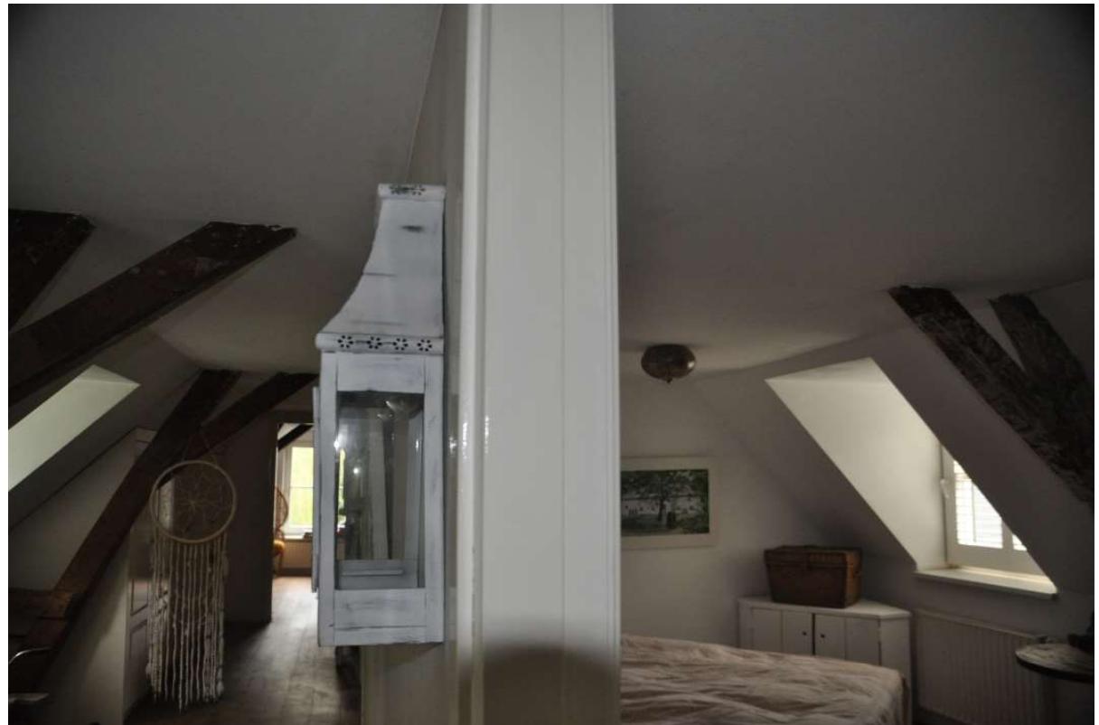
Door op de zolder gelijktijdig naar de beide delen van de kap te kijken, krijgt men een juiste indruk van de hele kap. Hier zijn drie spanten zichtbaar. In de muur, die aansluit aan de schuine muur naast het dakvenster, is een vierde spantbeen verborgen. Hier zijn het middeldeel van de kap links en het middendeel van de kap rechts samen te zien. Aan de bovenzijde worden de twee spantbenen (en korbelen) door middel van een debalk van het nokgebint met elkaar verbonden.
