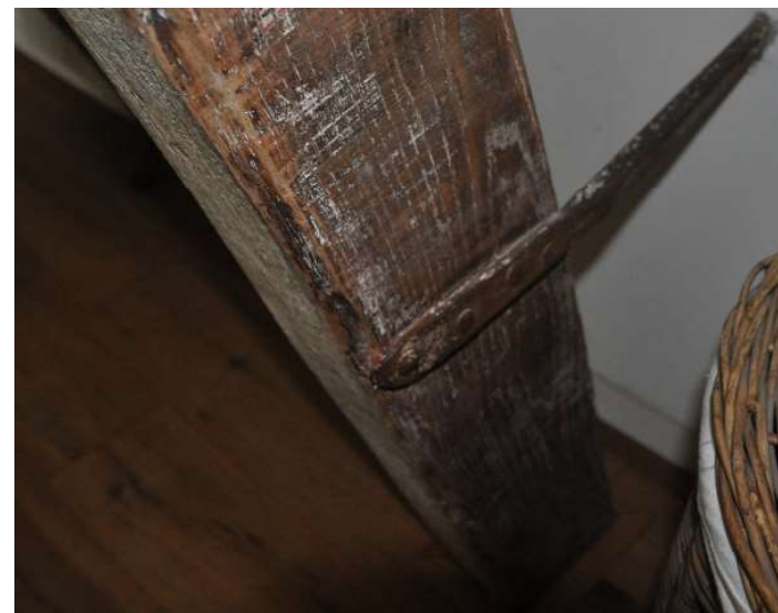
Boven Links en rechts: in de badkamer is een recht spantbeen zichtbaar waarvan de onderzijde in een betegeld muurtje is opgenomen. De telmerken zijn hier niet duidelijk waarneembaar, omdat deze in het verleden onder andere met verf zijn bedekt.
