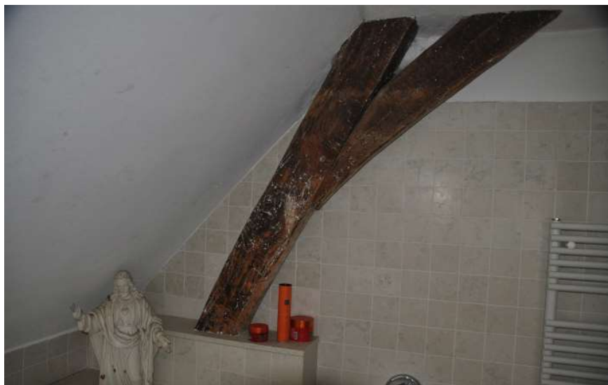
Onder Links en rechts: de krommer die tegenover slaapkamer 1 staat, heeft een aantal duidelijke gebruikssporen. Aan de onderzijde vallen twee donkerkleurige plekken op. De onderste is een restant van een houten dwarsverbinding, zoals die ook op het spantbeen daarachter is aangebracht. Daarboven wellicht de plaats waar ooit een schoor heeft gezeten.
