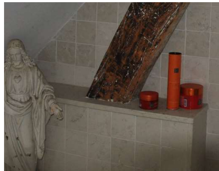
Boven Links en rechts: in de badkamer is een recht spantbeen zichtbaar waarvan de onderzijde in een betegeld muurtje is opgenomen. De telmerken zijn hier niet duidelijk waarneembaar, omdat deze in het verleden onder andere met verf zijn bedekt.
