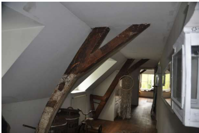
Onder Links en rechts: de krommer die tegenover slaapkamer 1 staat, heeft een aantal duidelijke gebruikssporen. Aan de onderzijde vallen twee donkerkleurige plekken op. De onderste is een restant van een houten dwarsverbinding, zoals die ook op het spantbeen daarachter is aangebracht. Daarboven wellicht de plaats waar ooit een schoor heeft gezeten.
