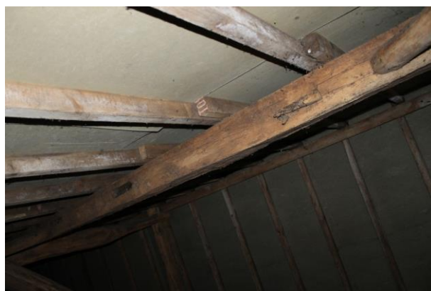
Aansluitingen van vakwerkwand
