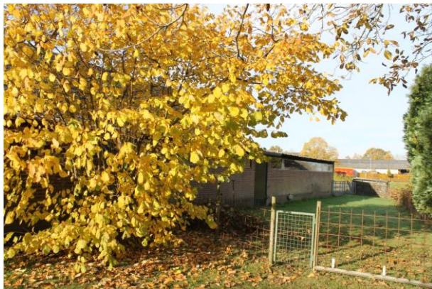
Achtergevel van de later aanbouw
