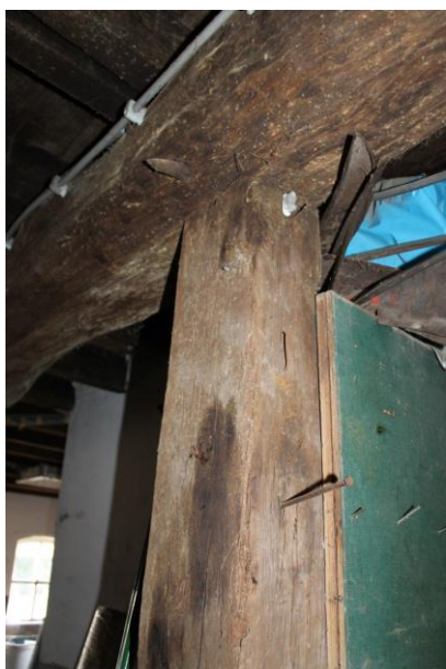
Aansluiting gebintstijl met dekbalk
