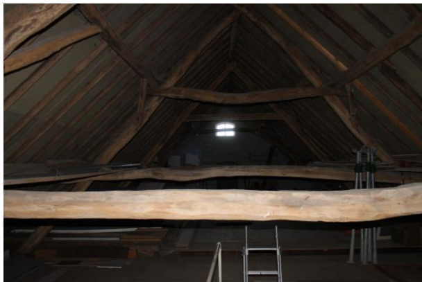
Vier oorspronkelijke spanten
