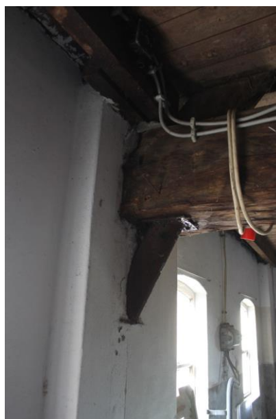
Gewijzigde aansluiting dekbalk met muur
