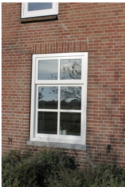
Vernieuw venster in bestaande sparing
