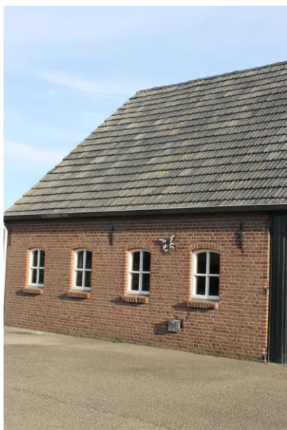
Betonnen stalvensters uit 1965
