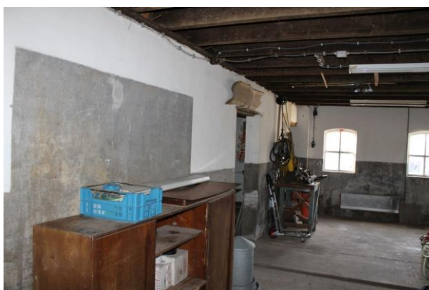
Oorspronkelijke muur in het bedrijfsgedeelte ten platse van gebint
