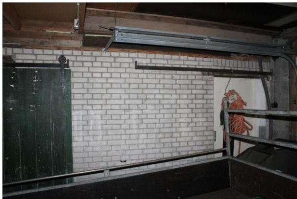
Latere muur onder dekbalk
