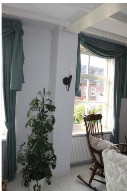
De aanzet van de brandmuur is nog ten platse van gebint
