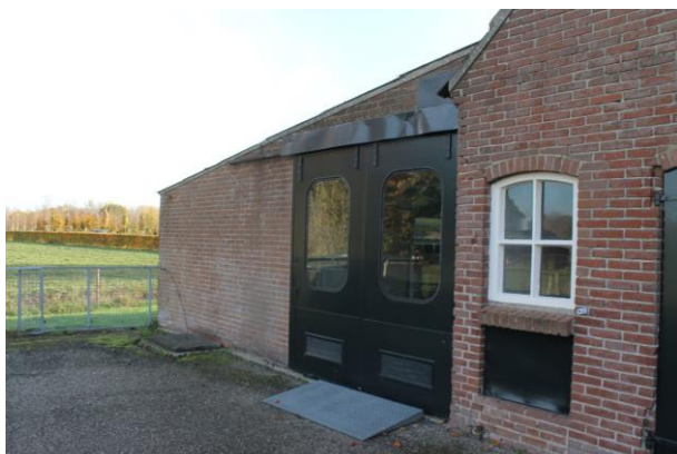
Aanbouw tegen achtergevel bedrijfsgedeelte
