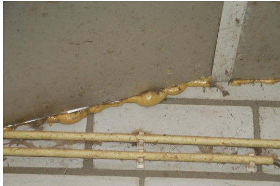
Afbeelding: Binnenzijde varkensstal afgesloten.
