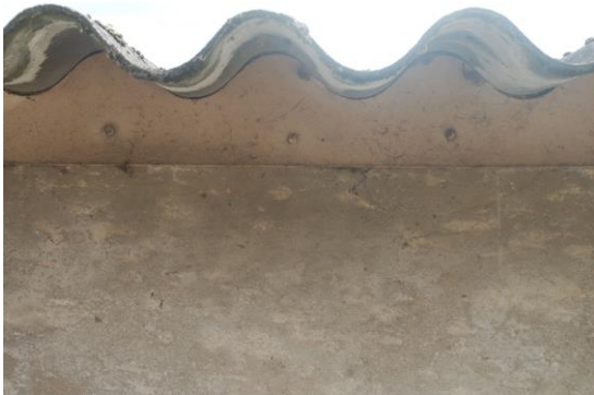
Afbeelding: Buitenzijde varkensstal afgesloten.
