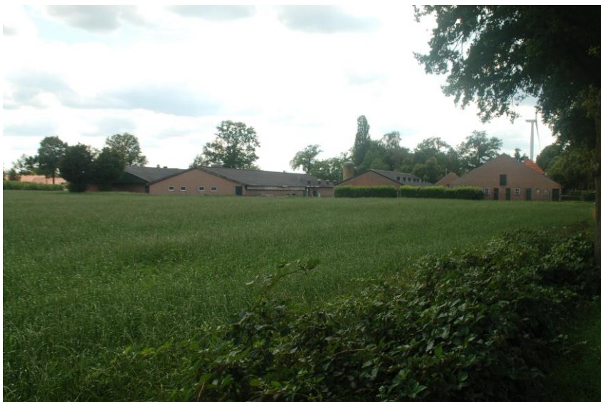
Afbeelding: achterzijde te slopen stallen met rechts de schuur.
