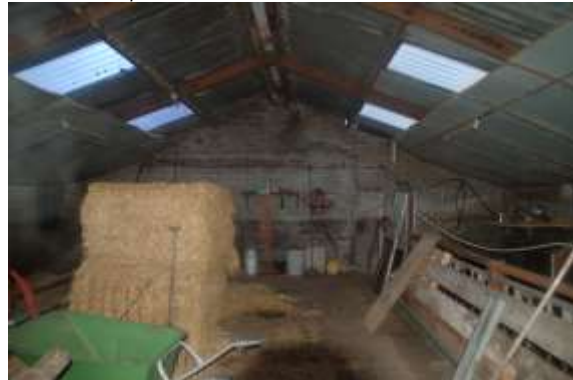
binnenkant te slopen stal
