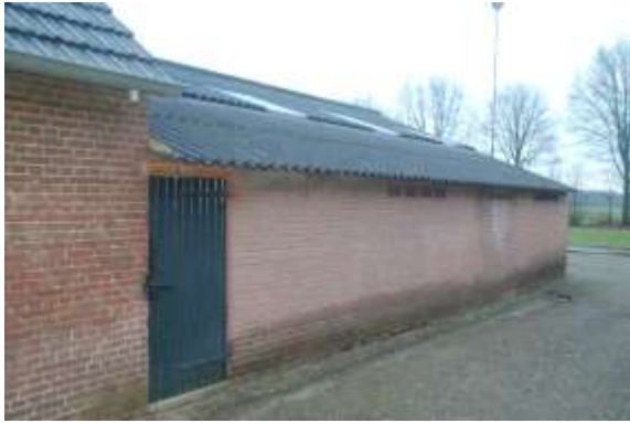
zijkant te slopen voormalige rundveeststal
