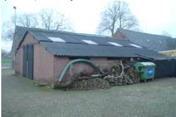
Achterzijde te slopen stal
