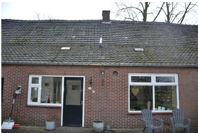
Gevelbeeld van achtergevel rechterzijbeuk. Aan
