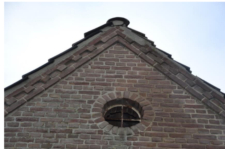
Detail van geveltop met rondvenster en sierlijst.
