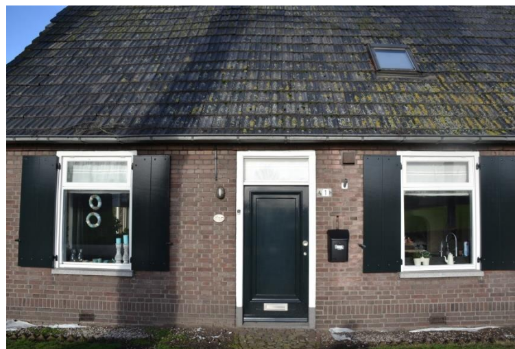
Voorgevel van het woongedeelte.
