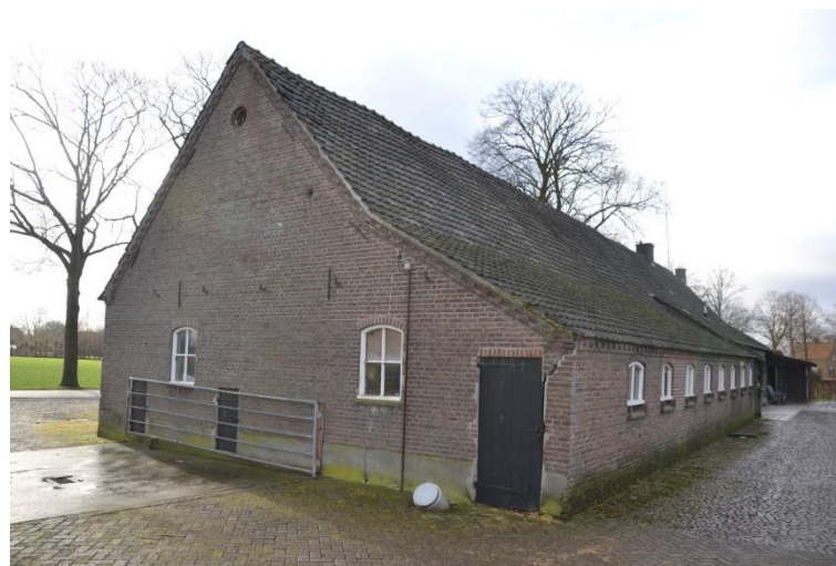
Achtergevel en rechterzijgevel.
