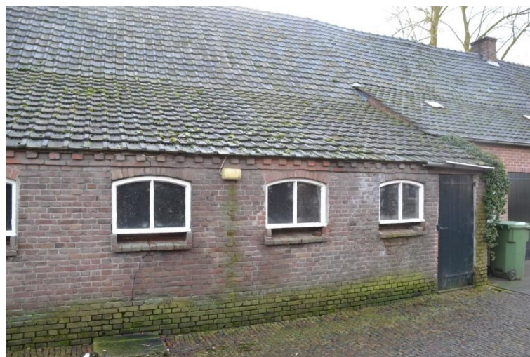
Rechterdeel van de achtergevel van de linkerzijbeuk met overgang naar de rechterzijbeuk.
