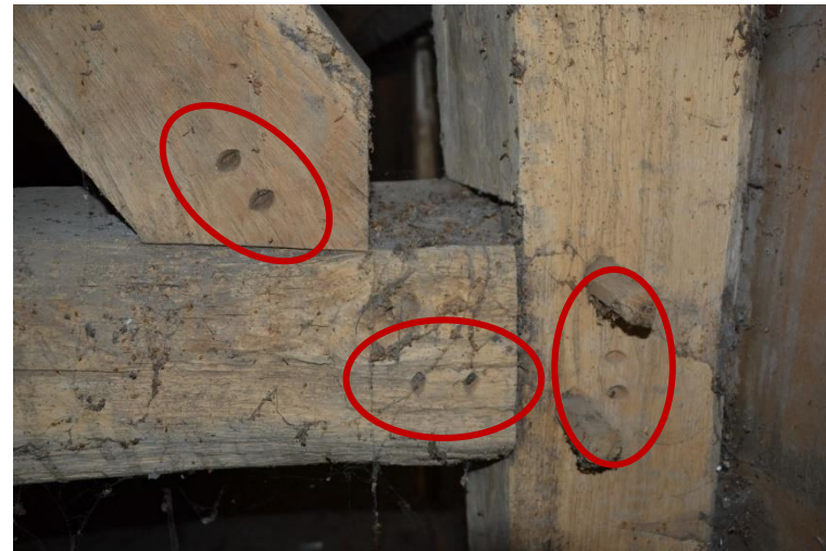
Detailfoto met telmerken in de vorm van gegutste ovaaltjes (2).
