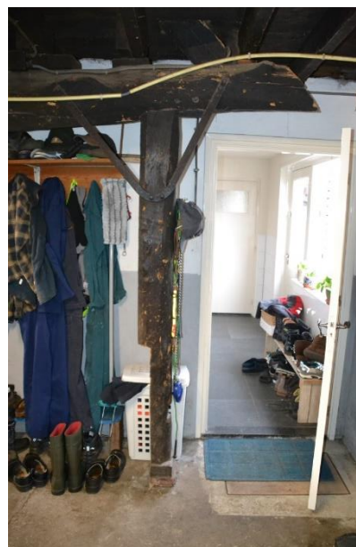
Eerste gebint/moerbalk voorbij de brandmuur.
