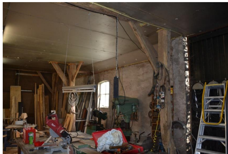
Het bedrijfsdeel richting de voorgevel gezien, het deel tussen de beide deeldeuropeningen bevat drie gebinten.
