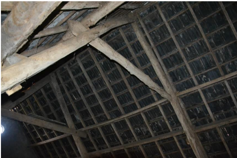
Eén van de oudere A-spanten.
