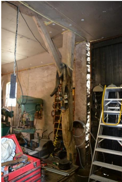
Gebintstijl aan de voorzijde van het 1 ste van drie voornoemde gebinten.
