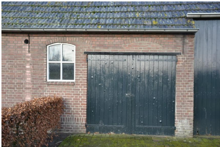
Stalvenster en staldeuren met twee afwijkende segmentbogen in het metselwerk.
