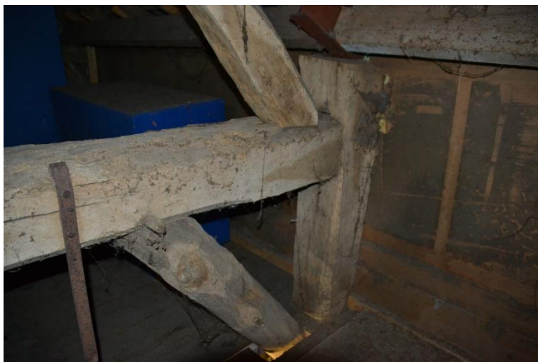
Aansluiting van de gebinten en de kap.
