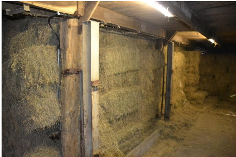
Zicht richting het derde gebint aan de veldzijde.
