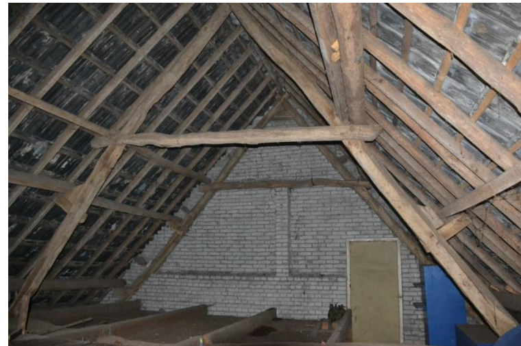
De kap van het bedrijfsdeel richting het woonhuis gezien. De tussenmuur van kalkzandsteen is later opgetrokken tussen voorstal en stal of schuur.
