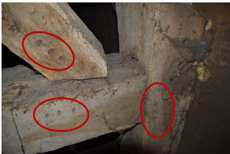
Detailfoto met telmerken in de vorm van gegutste ovaaltjes (3).
