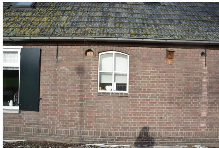
Vierruits stalvenster uiterst links in het bedrijfsgedeelte.
