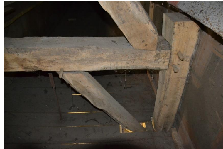
Aansluiting van de gebinten en de kap.
