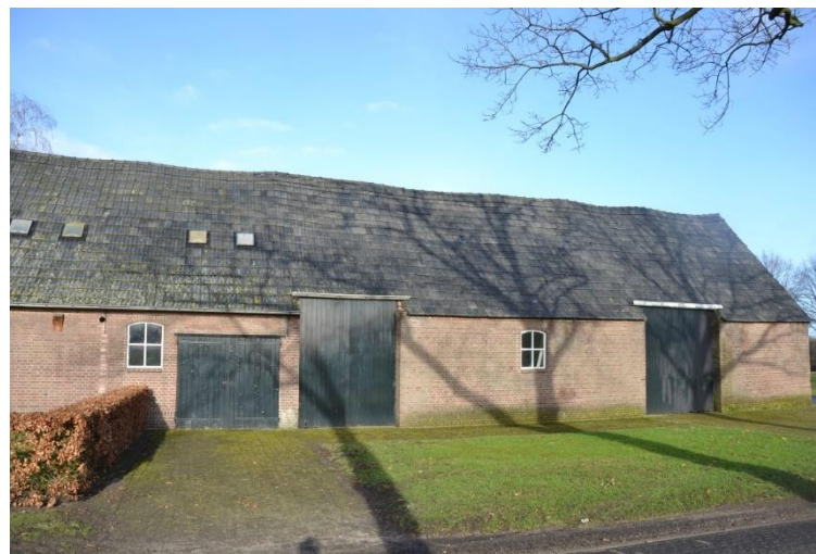
Voorgevel van het bedrijfsgedeelte.
