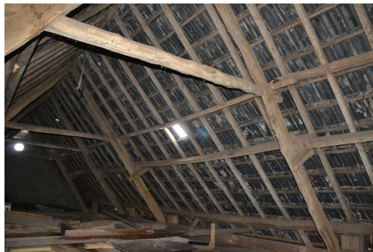
Zicht op de kapconstructie, richting rechterzijgevel gezien.
