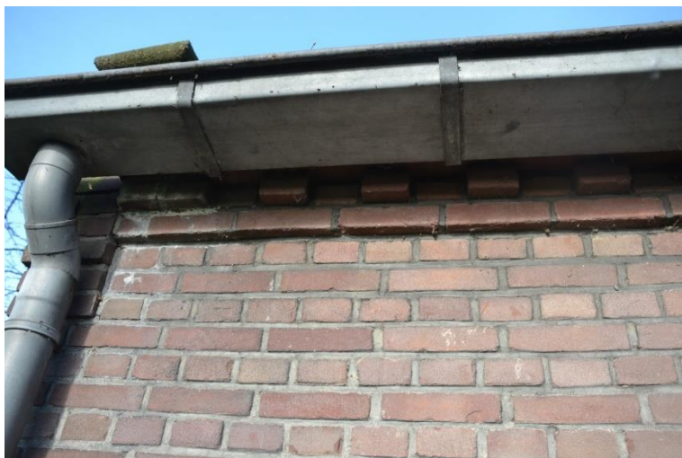
Detail metselwerk, goot en bloktand.
