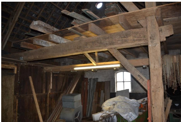
Het gebint voorbij het tweede paar deeldeuren.
