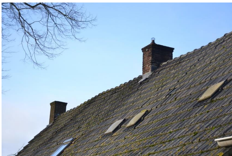
Detail van het dakvlak met muldenpannen, schoorstenen en vier van de vijf dakvensters.
