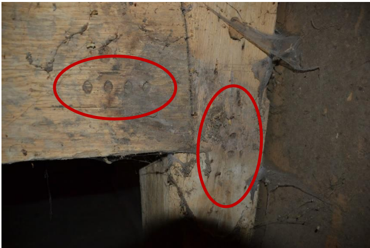
Detailfoto met telmerken van vier gegutste ovaaltjes (4).
