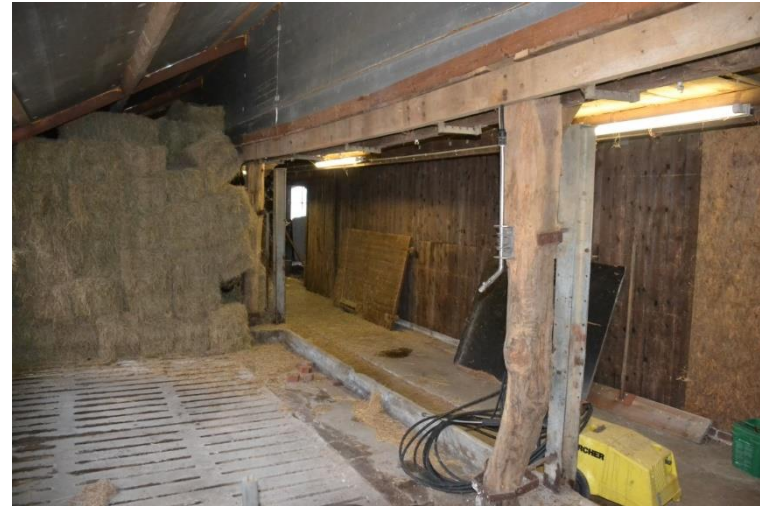
Het gedeelte tussen beide deeldeuropeningen aan de veldzijde (achtergevel) van de boerderij. De houten wand rechts is de later aangebrachte scheidingswand.
