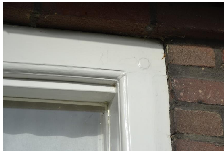
Detail van één van de gepende kozijnen.
