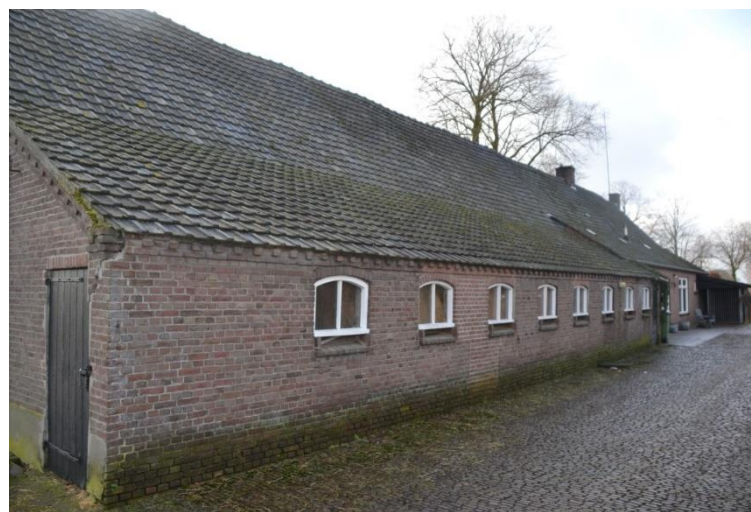
Achtergevel van de zijbeuk t.h.v. het bedrijfsgedeelte.
