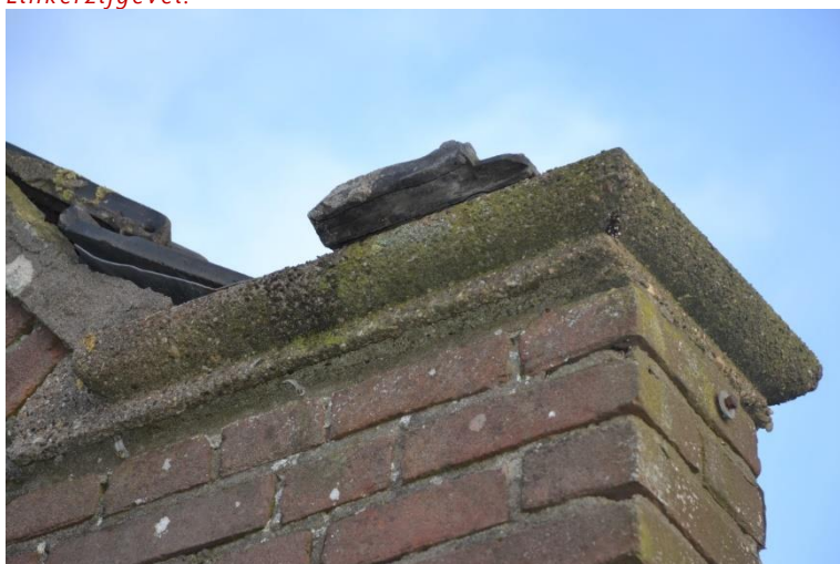
Schouder met dekplaat van cement of beton.
