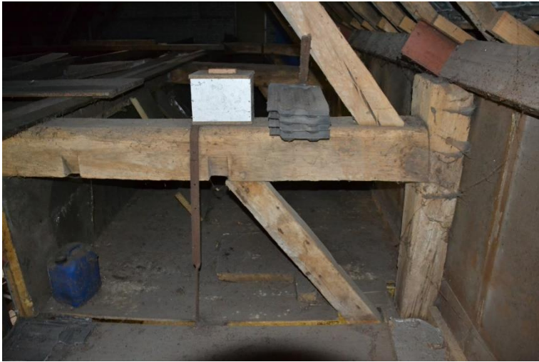
Aansluiting van de gebinten en de kap.
