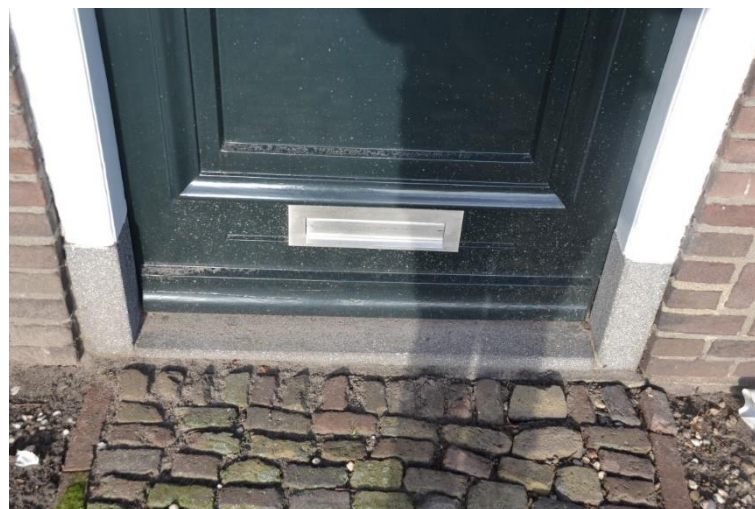
Detail voordeur met granito dorpel en neuten.
