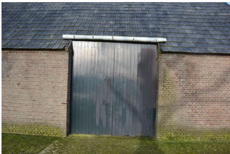
De tweede deeldeuropening rechts in de gevel.
