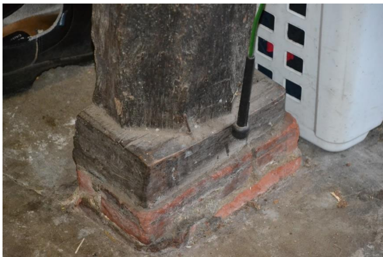
Houten slof en gemetselde poer onder de gebintstijl.
