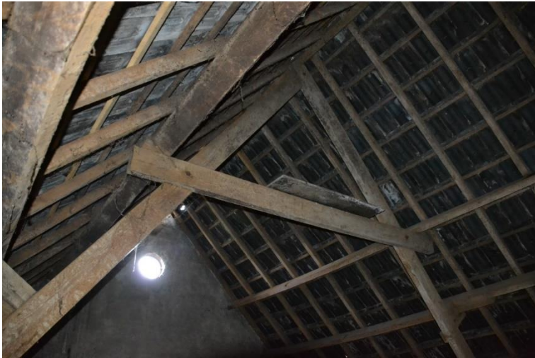
Het spant dat na de bouwtijd is vernieuwd.
