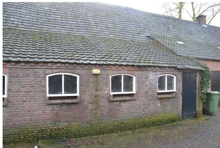
Overgang van de linkerzijbeuk naar de hogere en terugliggende rechterzijbeuk.
