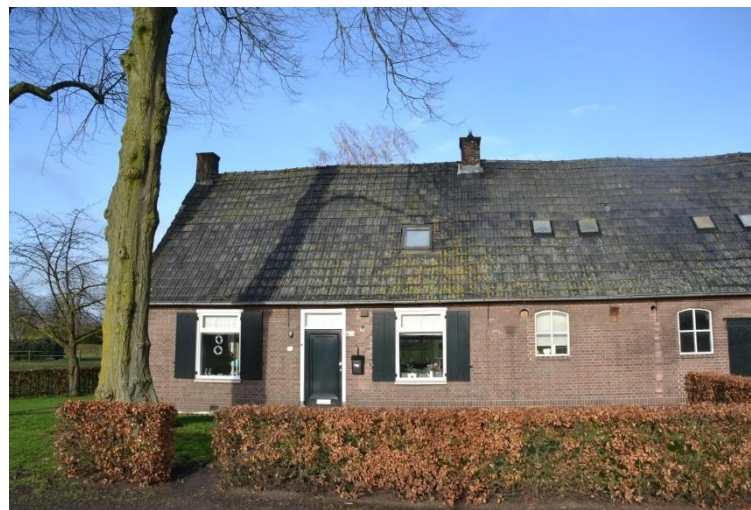
Voorgevel van het woongedeelte.
