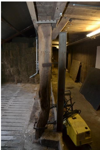
1 ste gebintstijl aan de veldzijde in gedeelte tussen beide deeldeuropeningen.
