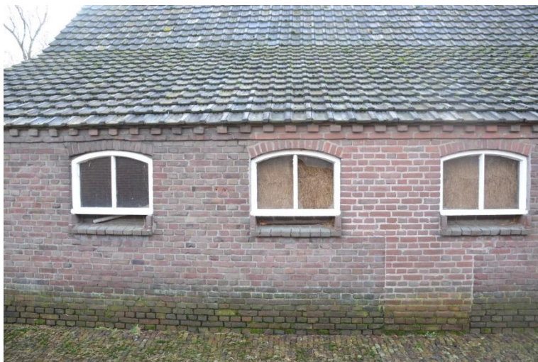
Detail van de stalramen links in de achtergevel met inboetwerk.
