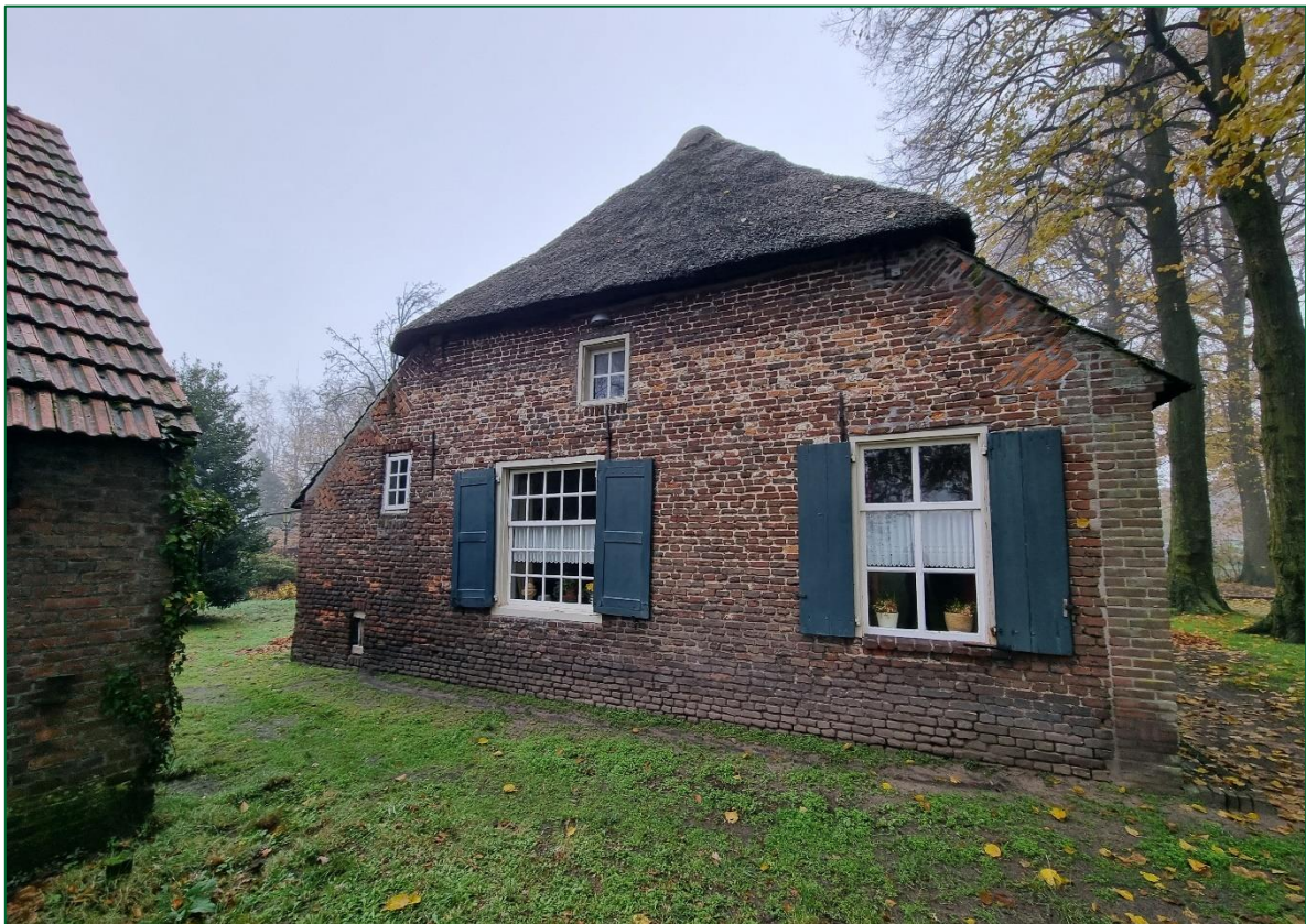
Afbeelding 7. Aanzicht oostelijke zijgevel Driehoek 21
