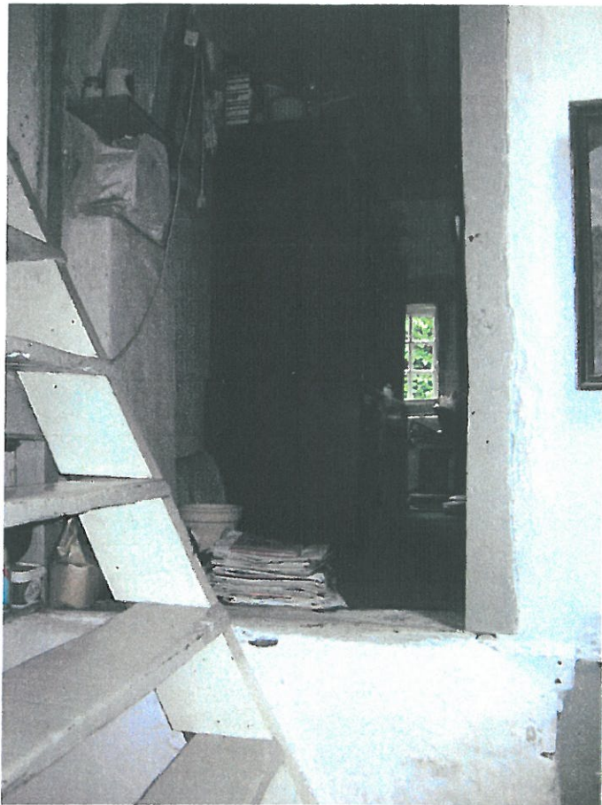
fig. 20 Opkamer met schuin- geplaatst kozijn.
