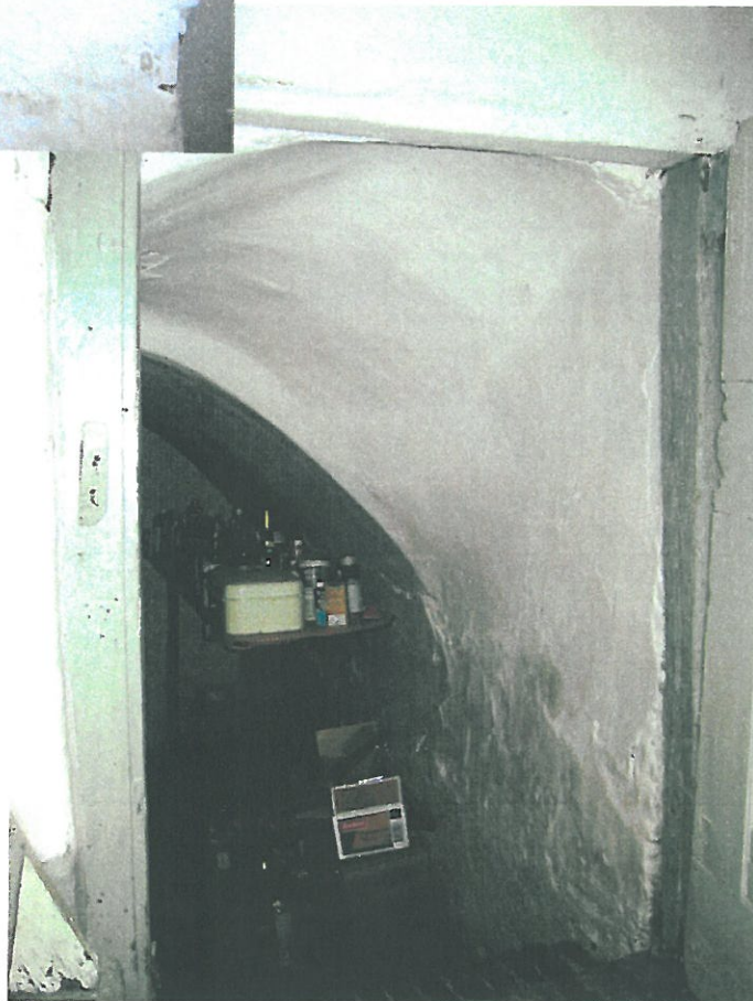
fig. 21 Kelder met tongewelf en kozijn
