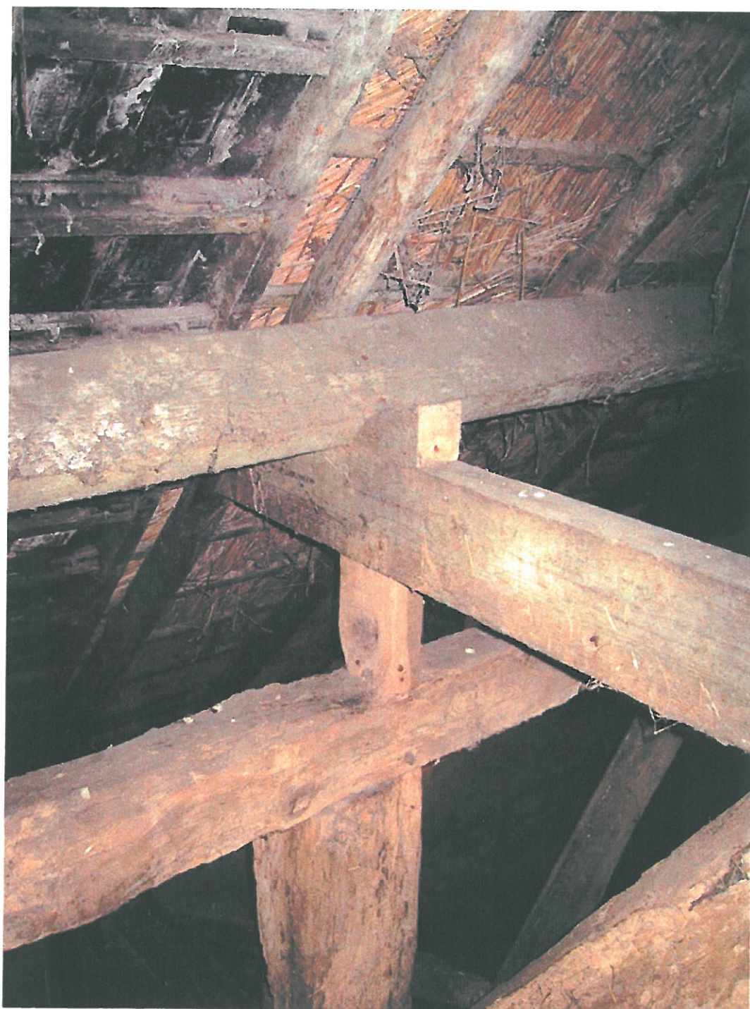
fig 30 Gebintstijl, wurm en 'stelten'. Blokdeel en gording aangebracht ter vergroting van de dakhoek.
