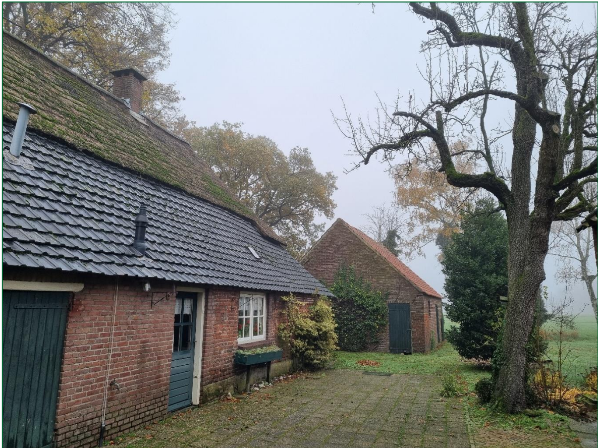
Afbeelding 8. Aanzicht achtergevel langgevelboerderij (woongedeelte) en vrijstaande stal/ garage
