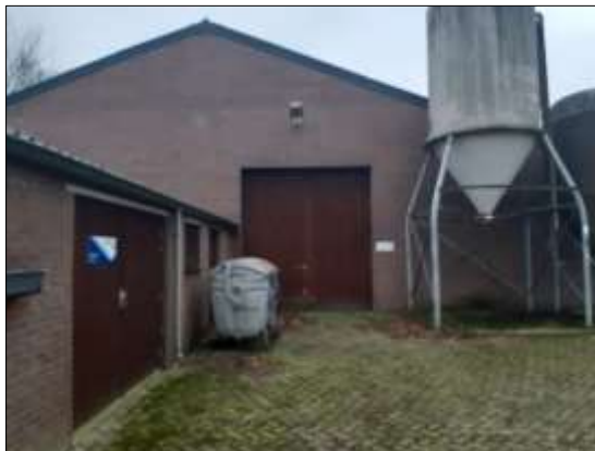
Foto 34 Links aanbouw stal met daarachter de stal
