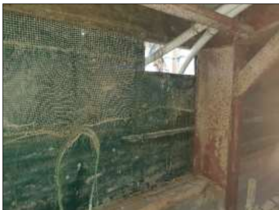
Foto 25 Gat buizen silo
