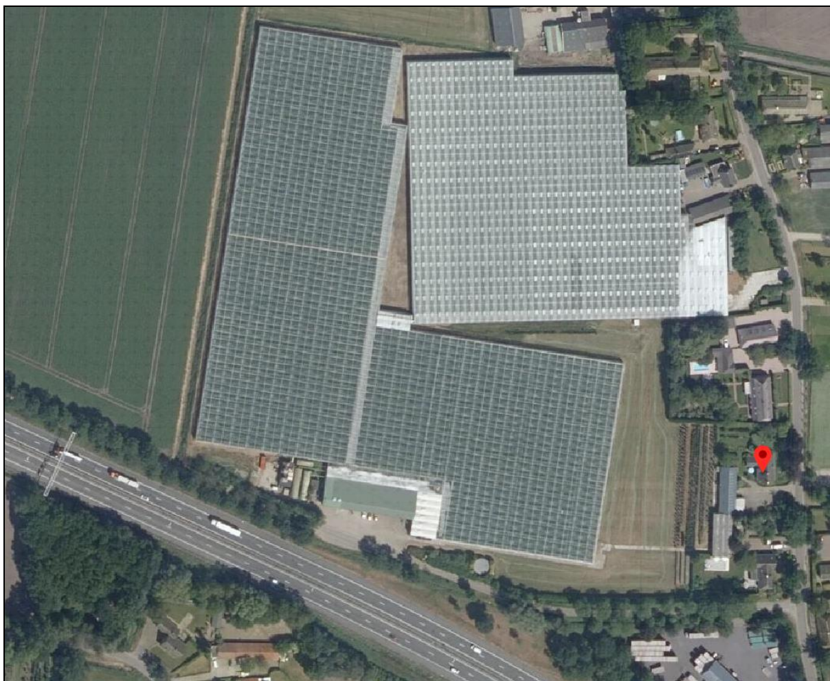
Figuur 4: Luchtfoto met het plangebied aan Boterwijksestraat 3a en 4. De ingang van het kassenbedrijf is gelegen aan de Hoolkot
