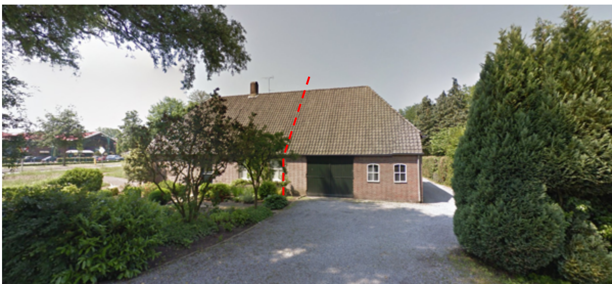
Foto van de bestaande woning aan de zijde van De Bollen. Bron: google.nl
