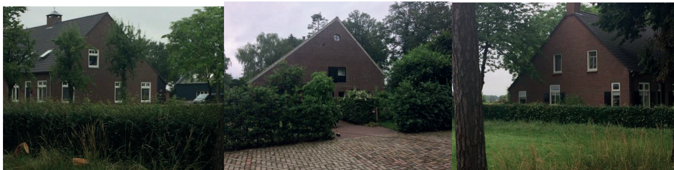
Foto's: Kopgevels van Achterste Heistraat 3, 9 en 5 laten de excentrische kap zien, evenals nr 15.
