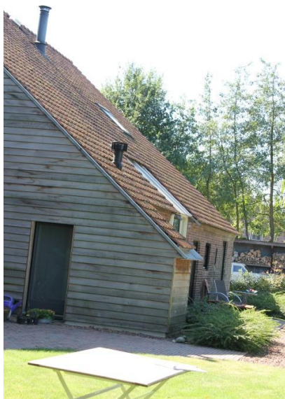
Gepotdekselde rechterzijgevel van de stal
