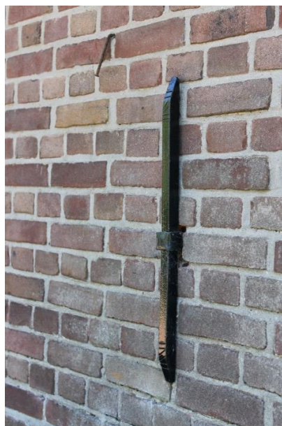
Het enige aanwezige muuranker
