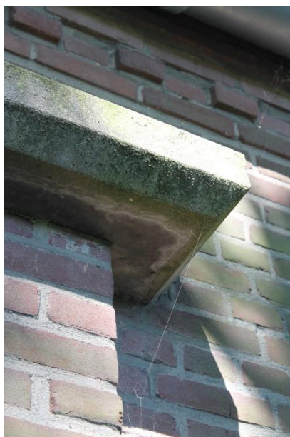
Afgeschuinde betonlatei boven voordeur
