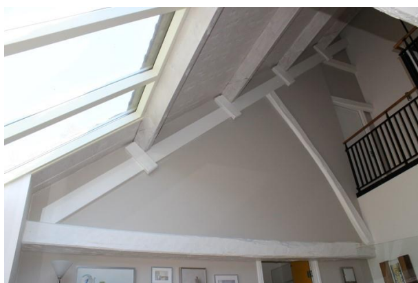
Spant in stalgedeelte
