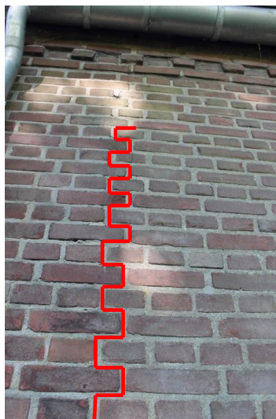
De vertande aanheling van het metselwerk met rechts het aangeheelde uit de jaren '50
