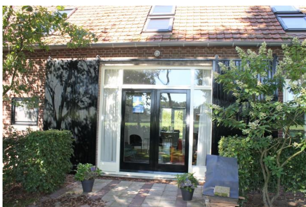
De opengeschoven staldeuren uit de jaren '30 met een recente puivulling
