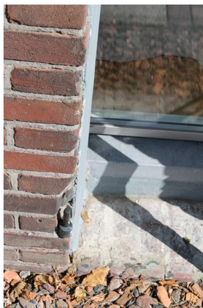
In de oude opening is,terugliggend een venster geplaatst. De oude duimen zijn nog aanwezig in de muur
