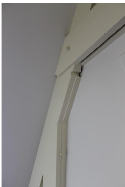
Gebout spantbeen met ligger in het woongedeelte
