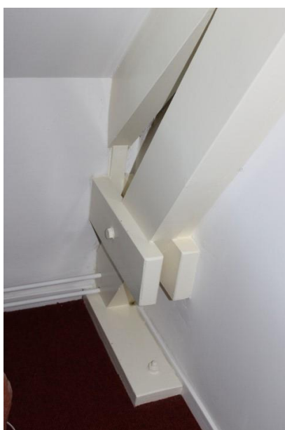
Naalldhouten spant met geboute onderdelen in het woongedeelte
