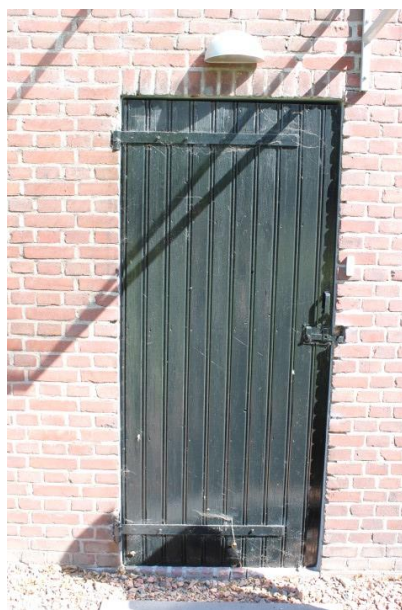
De vernieuwde staldeur met het oorspronkelijke hang- en sluitwerk
