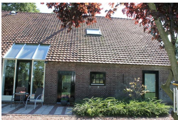
Het rechterdeel van de achtergevel van de stal
