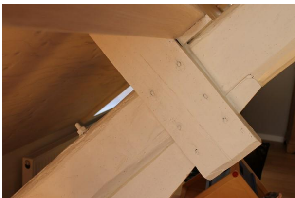
Spantbeen met daarop een genageld schoor van de gording
