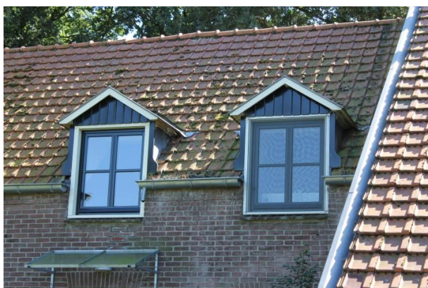
De vermoedelijk later aangebrachte dakkapellen
