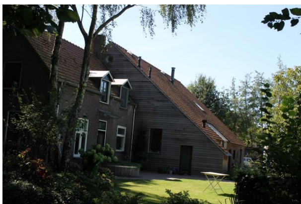
Gepotdekselde rechterzijgevel van de stal
