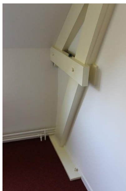
Naalldhouten spant met geboute onderdelen in het woongedeelte
