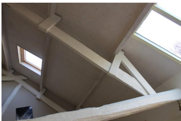
Ligger met disselslag waarop gezaagd spantbeen en nieuwe gordingen en dakbeschot
