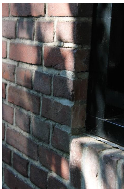
Het ingezaagde metselwerk bij de vervangen stalramen
