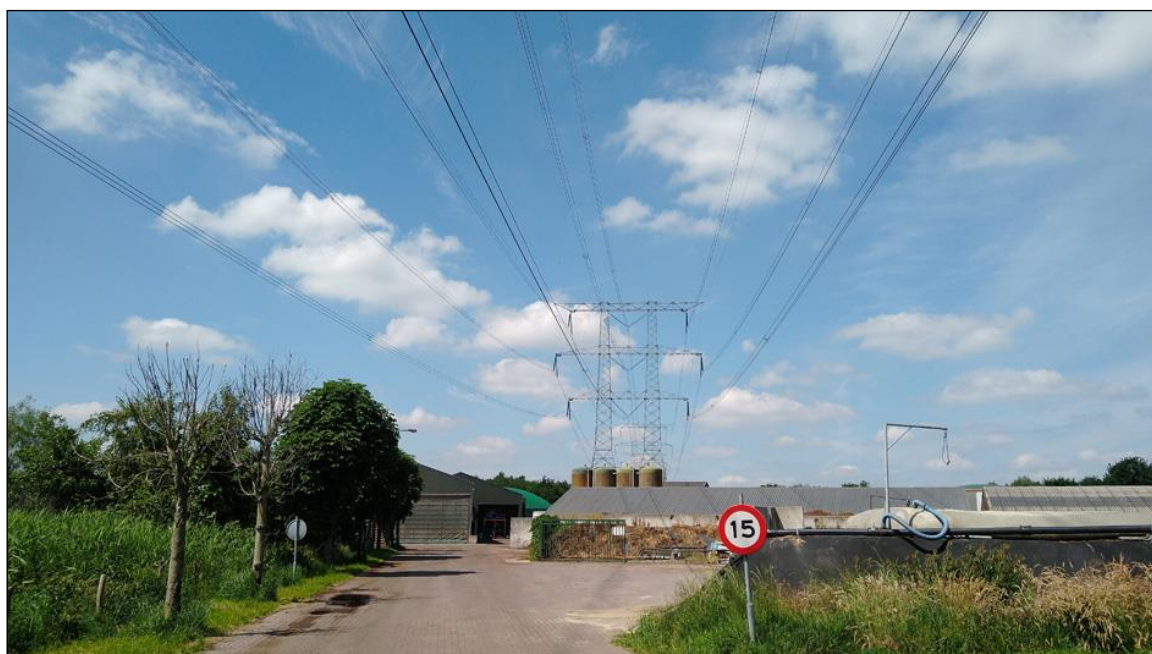
Figuur 5: Huidige situatie besluitgebied: tweede ontsluiting bedrijf aan de Langendonksedijk. De hoogspanningsmast ter plaatse loopt over het bedrijf.
