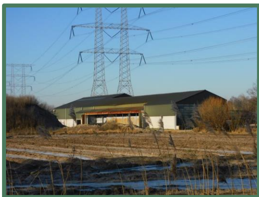
Bedrijfsgebouw, huidige situatie (gedeeltelijk gesaneerd)
