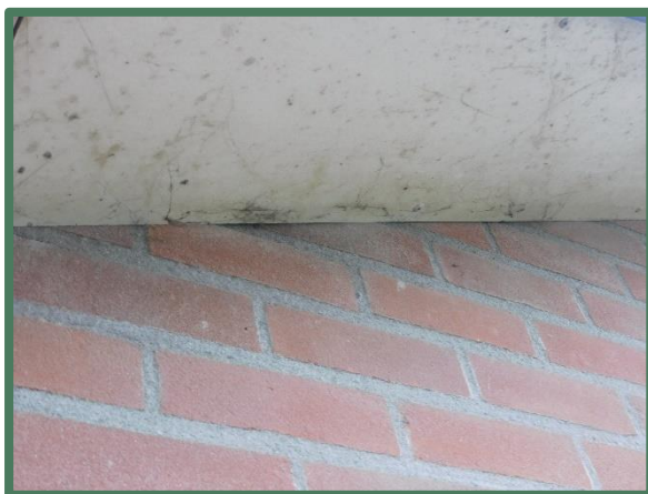
strakke aansluiting dak en muur
