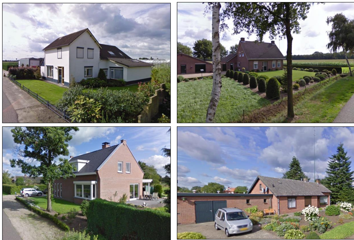
Figuur 8: Bebouwing in omgeving van plangebied (Bron: Google Streetview). De foto linksboven betreft de woning aan De Maneschijn 4.
