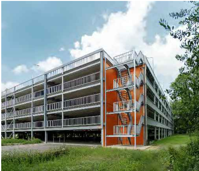
Herkenbaar stijgpunt parkeergarage
