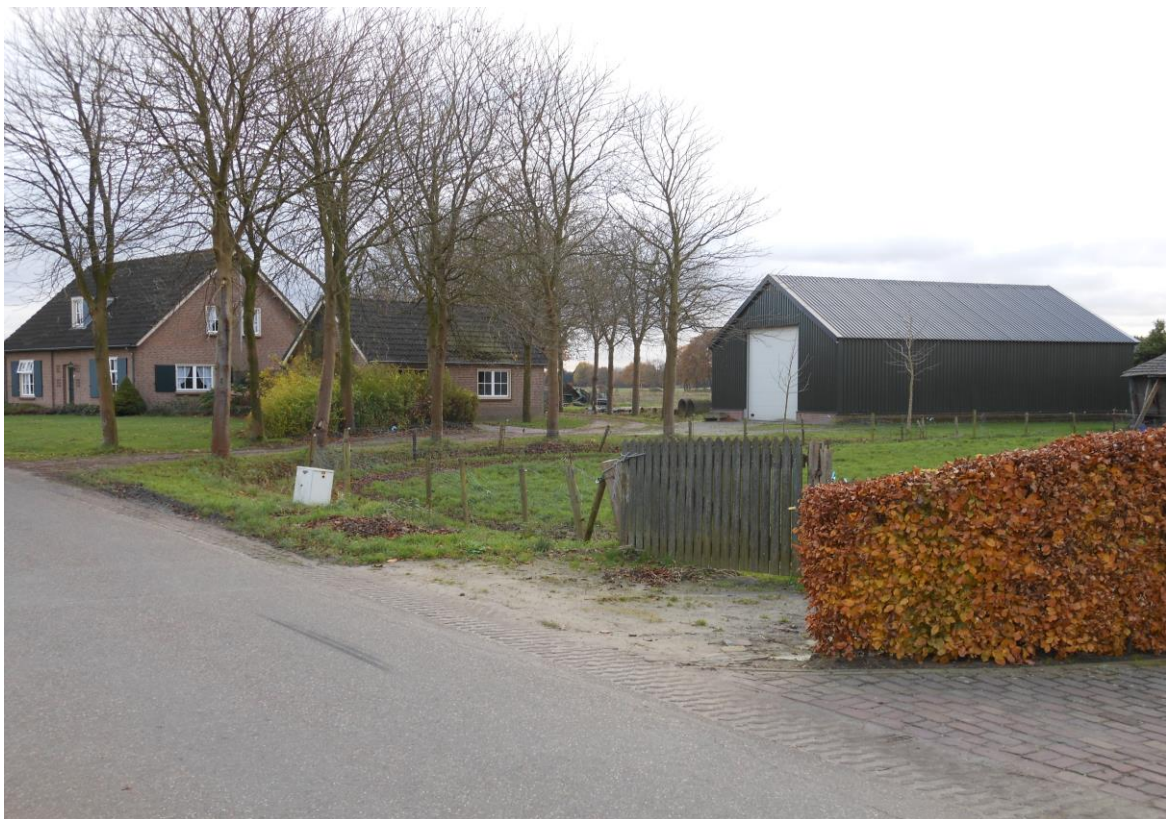
Fig. 5 belendende bebouwing zuidzijde (links).
