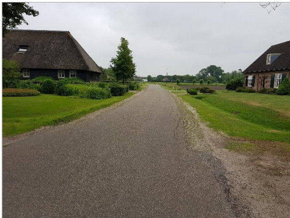
Figuur 7. Lubberstraat richting zuiden
