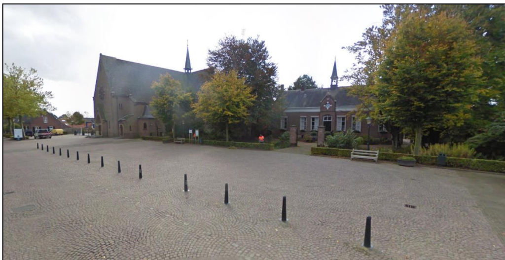
Figuur 2.2: De voormalige kerk en pastorie (Bron: Google Streetview)
