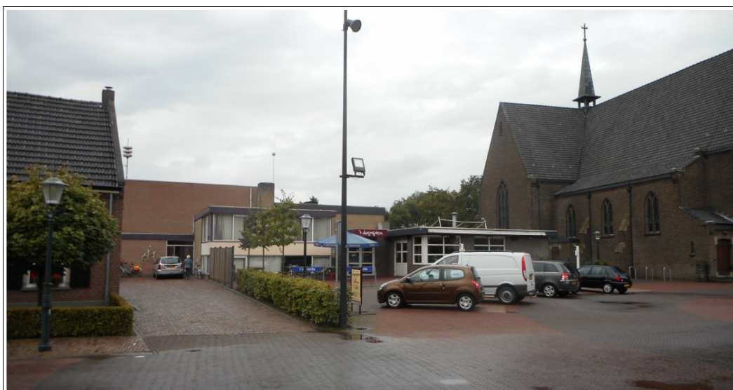
f4.3 Foto bestaande situatie nabij woning Kerkstraat 12
