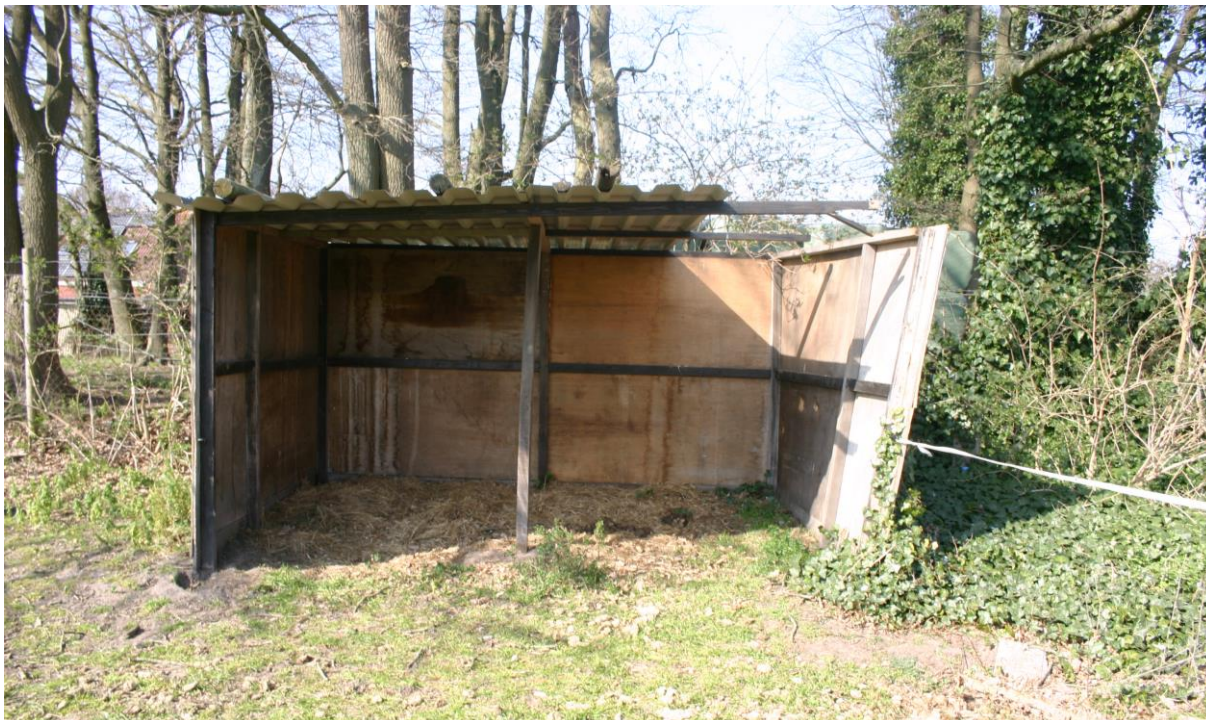
Figuur 4.4.2. Een van de twee enkelwandige ponystalletjes het plangebied.
