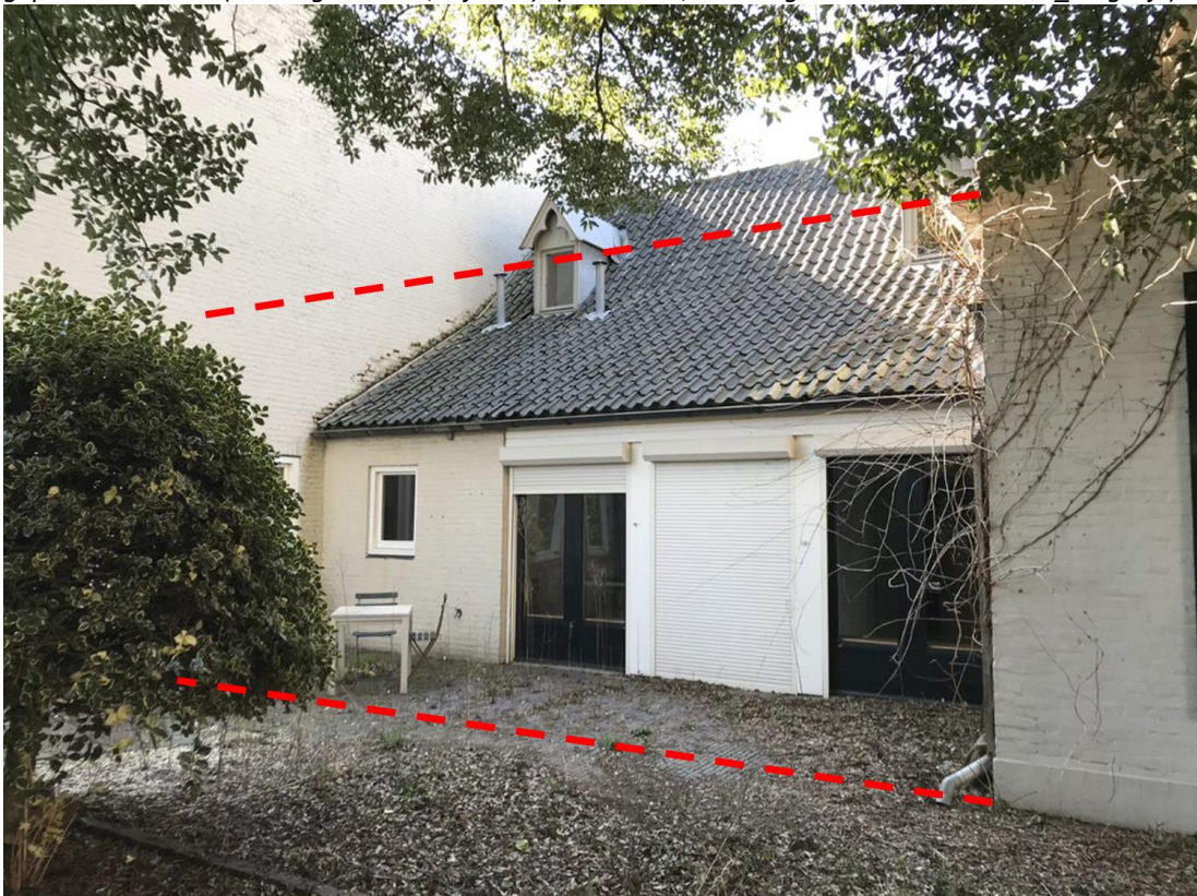
Figuur 3 Locatie geplande uitbreiding met globaal de boven- en onderkant van de nieuwe gevel.
