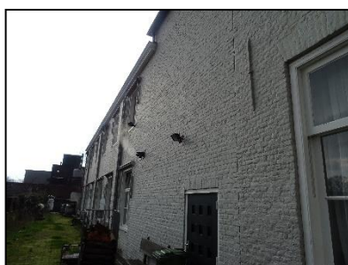
Figuur 10. Westelijke bebouwing met siertuin.
