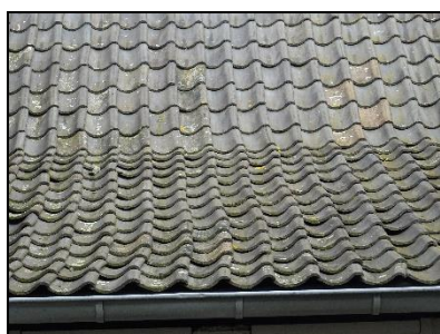
Figuur 20. Ruimte onder (scheve) dakpannen geschikt als verblijfplaats vleermuizen.
