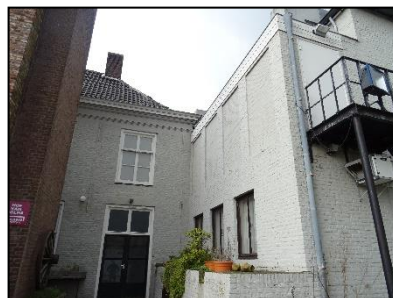
Figuur 7. Zuidelijke bebouwing met trap en achterdeuren.
