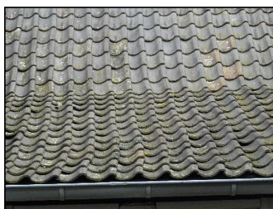
Figuur 14. Ruimte onder dakpannen geschikt als broedplaats huismus.
