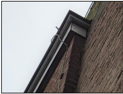
Figuur 17. Ruimte tussen muur en beplating geschikt als broedplaats gierzwaluw.
