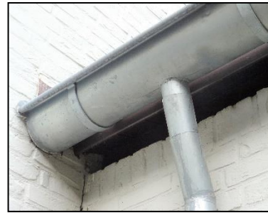
Figuur 19. Ruimte onder dakgoot geschikt als broedplaats gierzwaluw.
