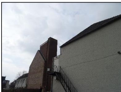
Figuur 6. Overzicht zuidelijke bebouwing.
