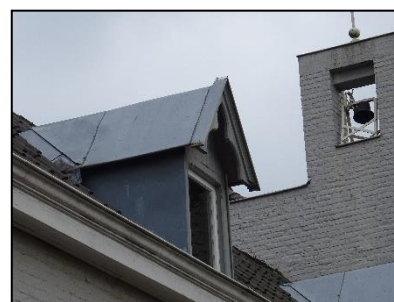
Figuur 16. Dakkapel geschikt als broedplaats gierzwaluw.
