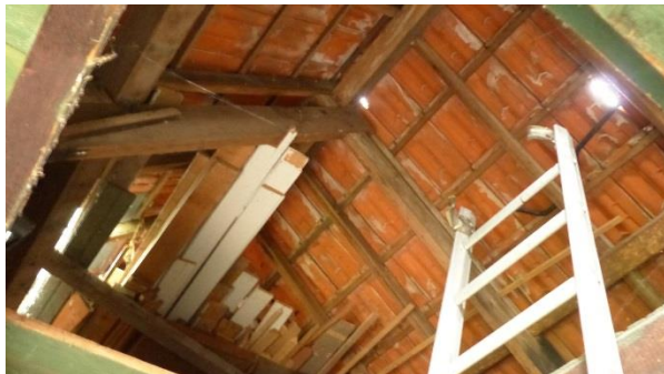
Figuur 4.. Binnenkant schuur
