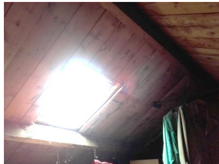
Figuur 5. Binnenkant woonhuis
