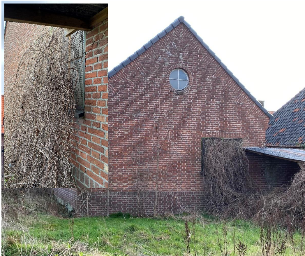
Afbeelding 6. Westzijde transformatorhuis (rooster)
