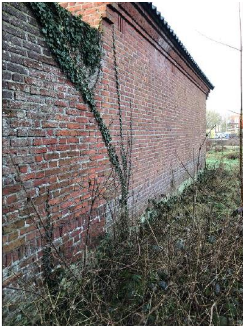
Afbeelding 5. Noordzijde transformatorhuis (geen openingen)
