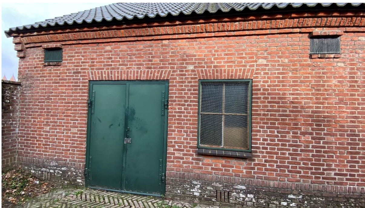
Afbeelding 4. Zuidzijde transformatorhuis (2 roosters)
