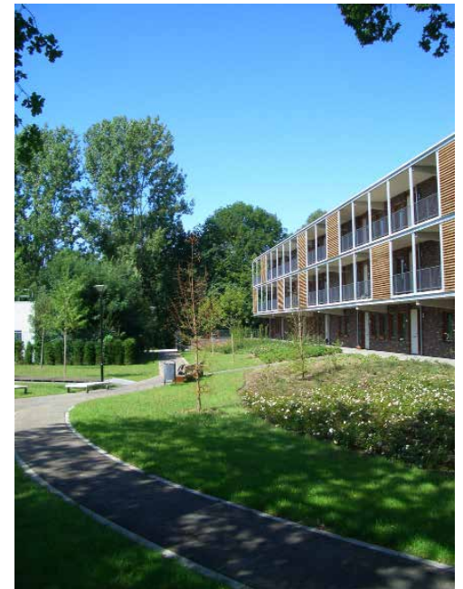
Intermediaire ruimte door overkragende verdieping
