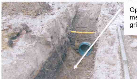
Figuur 5.1 Principe foto van toe te passen systeem van IT-riool in een bed
