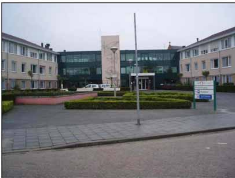
6a. De hoofdingang van het verpleeghuis aan de Sint Jorisstraat.
