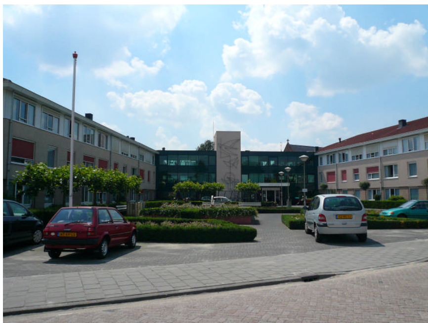
Uitbreidingslocatie aan de entree aan de St. Jorisstraat
